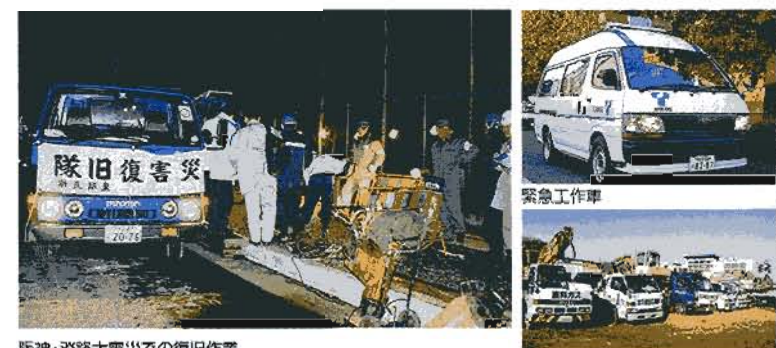
阪神・淡路大震災での復旧作業
